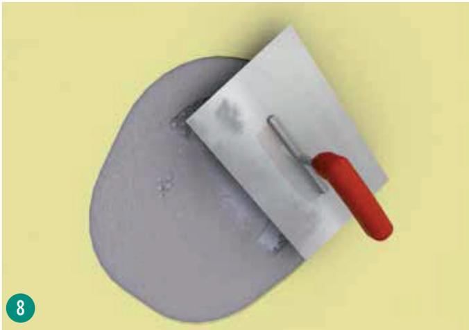
**Foto 8** - Aplicar una capa de mortero Pulmor RVTerm y embeber un parche de malla de fibra de vidrio Pulmor de forma que tenga un solape mínimo de 5 cm a cada lado del borde de la malla inicial. Una vez endurecida esta capa, aplicar una mano de imprimación Pulmor Primercrl. Delimitar el área a revestir como acabado con cinta de carroceros bastante ancha.
