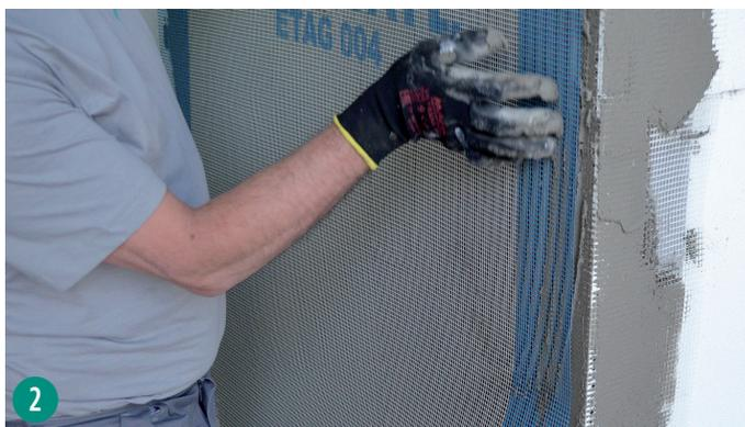
Foto 2 - Los tramos de malla colindantes tienen que solapar como mínimo 10 cm (nunca menos de 5 cm). Solapar también con la malla de los perfiles de PVC de protección de bordes. El borde azul de 5 cm de la malla Pulmor evidencia el final de la malla y zona de solape. La línea azul gruesa, paralela al borde azul, marca el solape de 10 cm.
