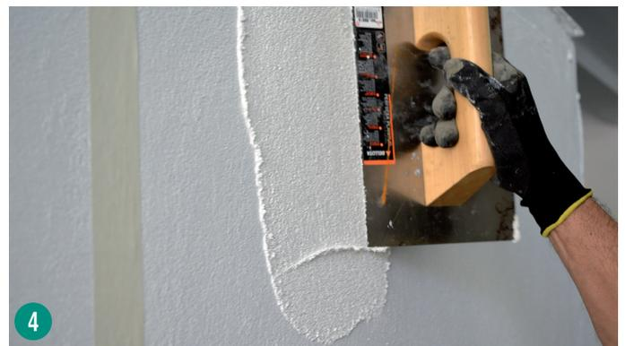
**Foto 4** - Es decir, de forma continua en un mismo paño de fachada y mediante juntas de trabajo para dejar bordes preparados y evitar empalmes de difícil ejecución entre diferentes paños.
