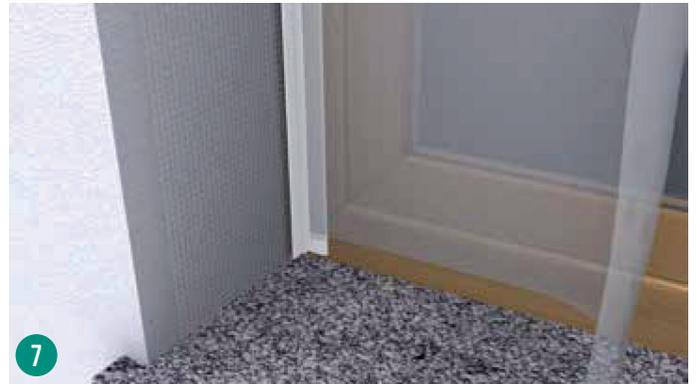
**Foto 7** - Sobre la lengüeta adhesiva pegar el plástico de protección de la ventana. La malla que viene incorporada quedará embebida en la capa de mortero.
