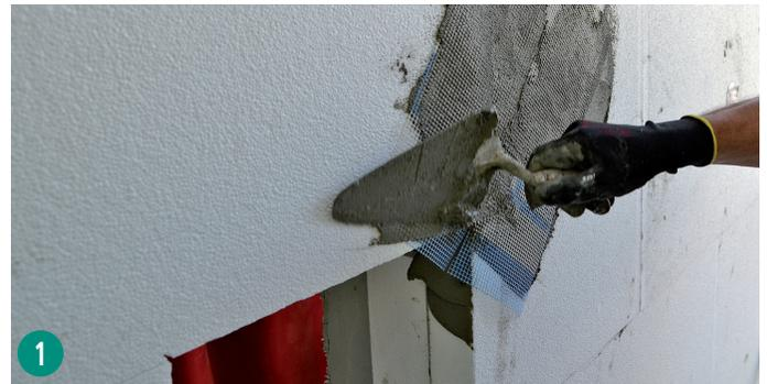
**Foto 2** - En su defecto se puede utilizar un trozo de malla Pulmor.
